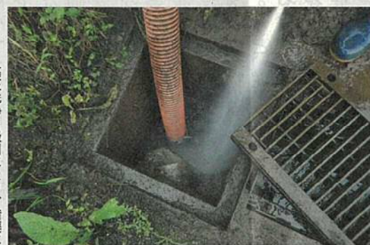
高圧洗浄と吸引により、暗渠に溜まった土砂を撤去
