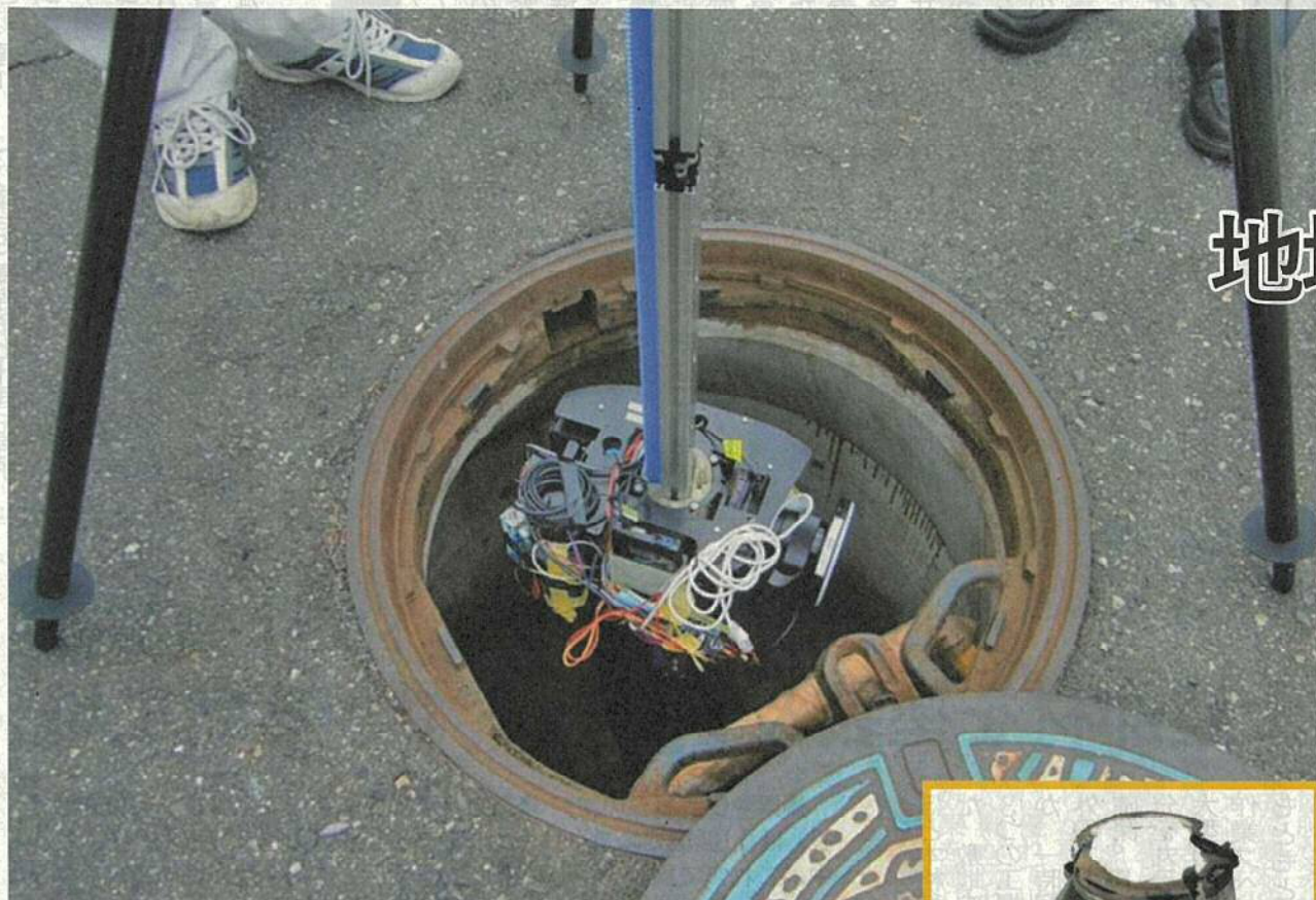
自動撮影機器でマンホール内部を計測
